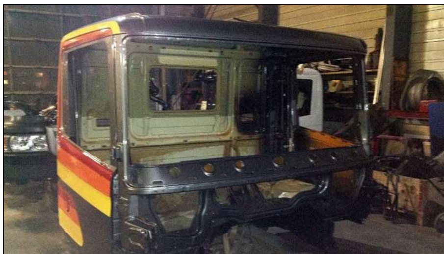
Baustelle: Auspuffrohrverlängerung (oben) und die Kabine fertig gespritzt vom Lackierer.
