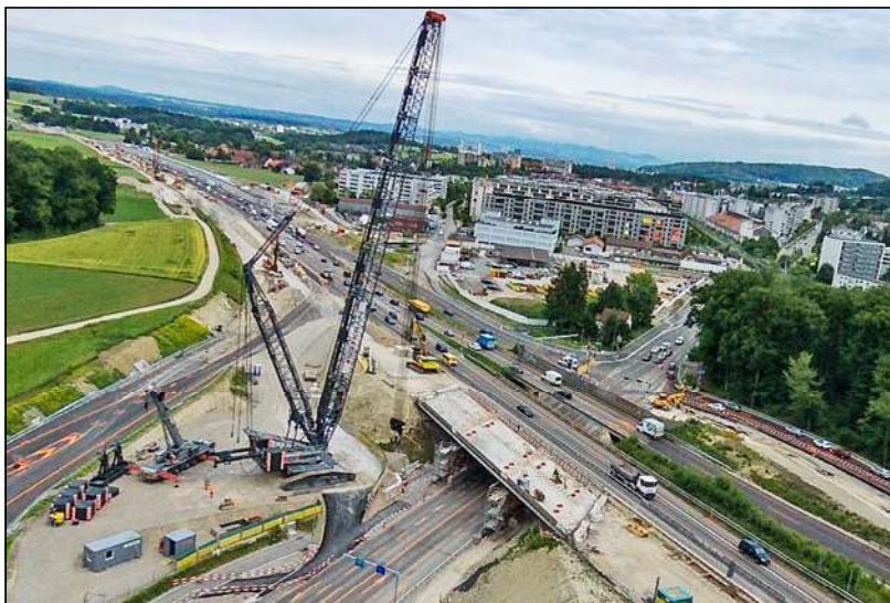
Noch komplett: Die Überführung über die Wehntalerstrasse (sechs Einzelteile).
