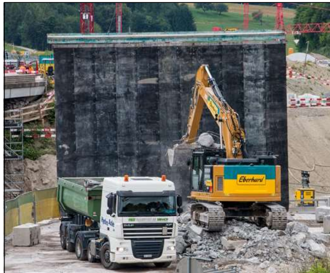
Abtransport: Ein kleinerer Bagger verlädt die Trümmer.
