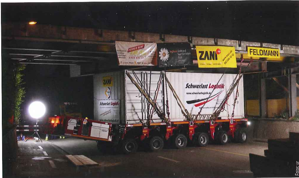
Statt Bagger: «Mit dieser «modularen Transporteinheit» hebt man locker eine Brücke ab.
