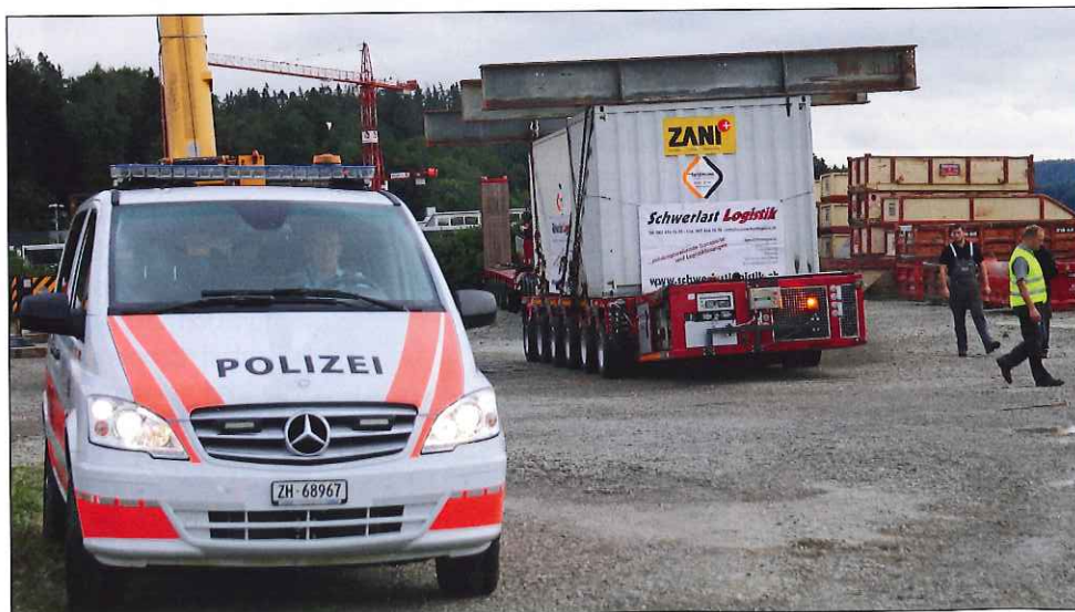
Vorbereitung: Auf den Stahlträgern auf dem Container verteilt sich später das Brückengewicht.
